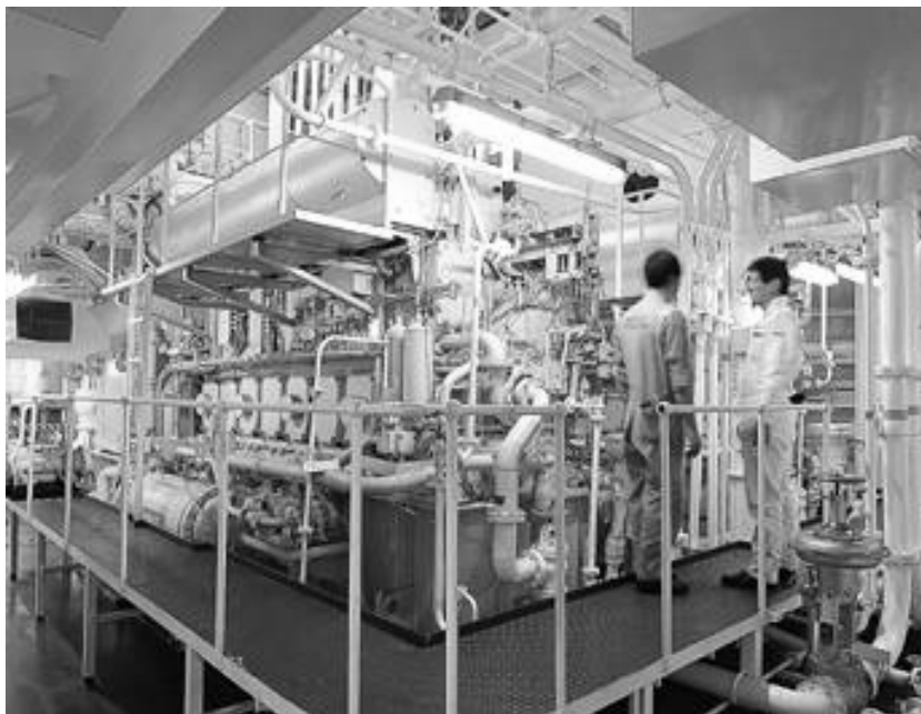
4.2.1.2.6 ábra Daihatsu gyártmányú nagy teljesítményű dízelgenerátor
