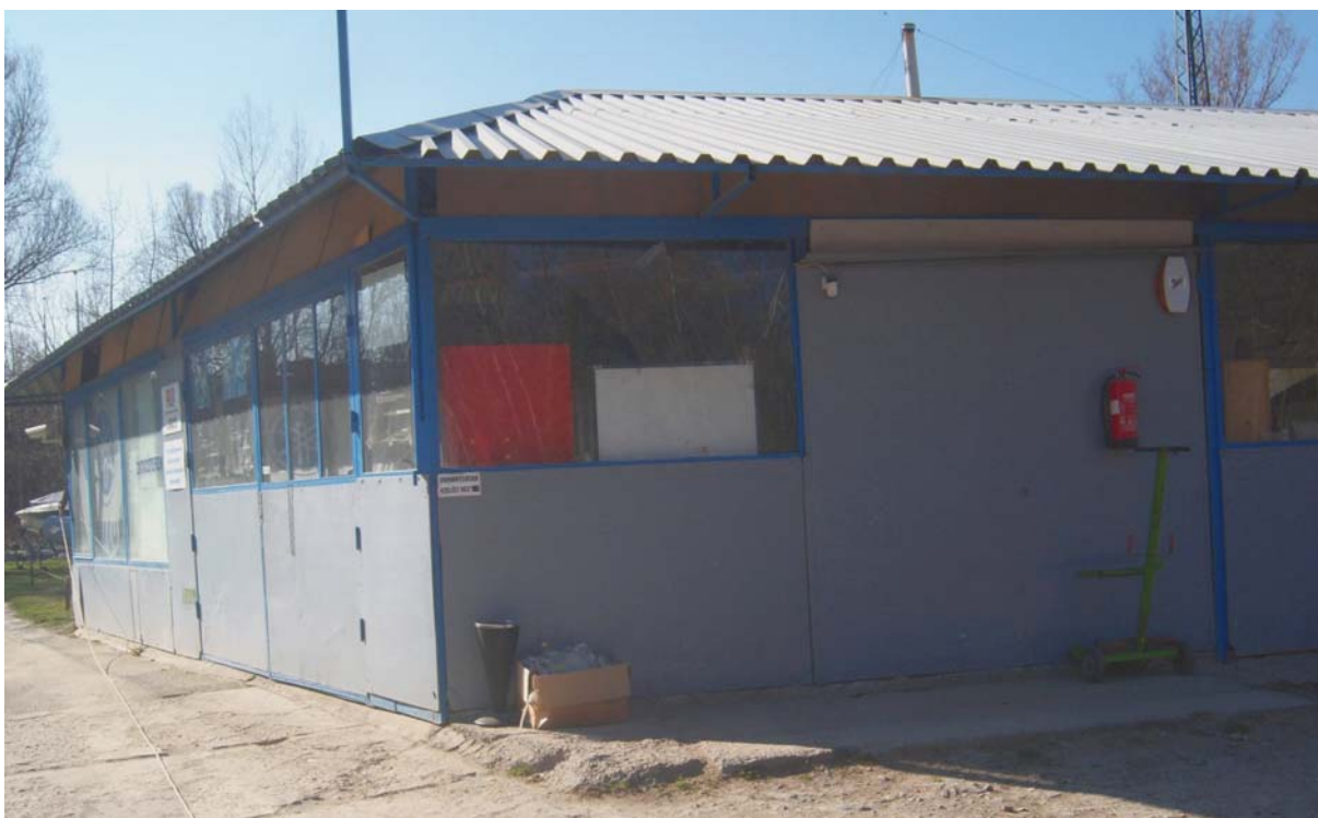
4. ábra: A 20-as tétel (felvonulási épület) vízpartra merőleges oldala
